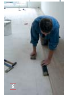
01 Die Eichendielen von Timberwise werden direkt auf die Baustelle geliefert. 02 Der Parkettleger schleift den Estrich vor dem Verlegen ab. 03 Der Kleber wird ohne Voranstrich aufgetragen, meist für zwei, drei Reihen im Voraus. 04 Anschließend werden die Dielen ins Kleberbett gelegt und festgeklopft. 05 Die noch vollen Pakete dienen als ideales Material, um die verlegten Dielen zu beschweren. 06 Mittels Schnur und Metallwinkel kontrolliert Heiner Reisener ständig, ob die Verlegung exakt erfolgt ist.
